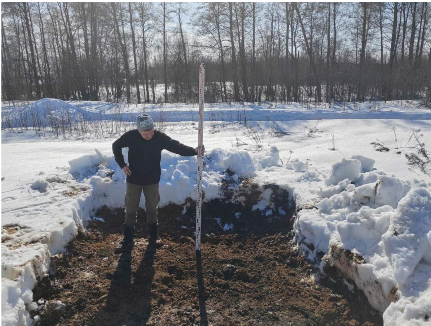
Илл. 18. Нижегородская обл., Городецкий р-н, межпоселковый газопровод к д. Каравеево - 2024 г. Шурф 2. Видовая фотография закопанного шурфа. Фото с С.
