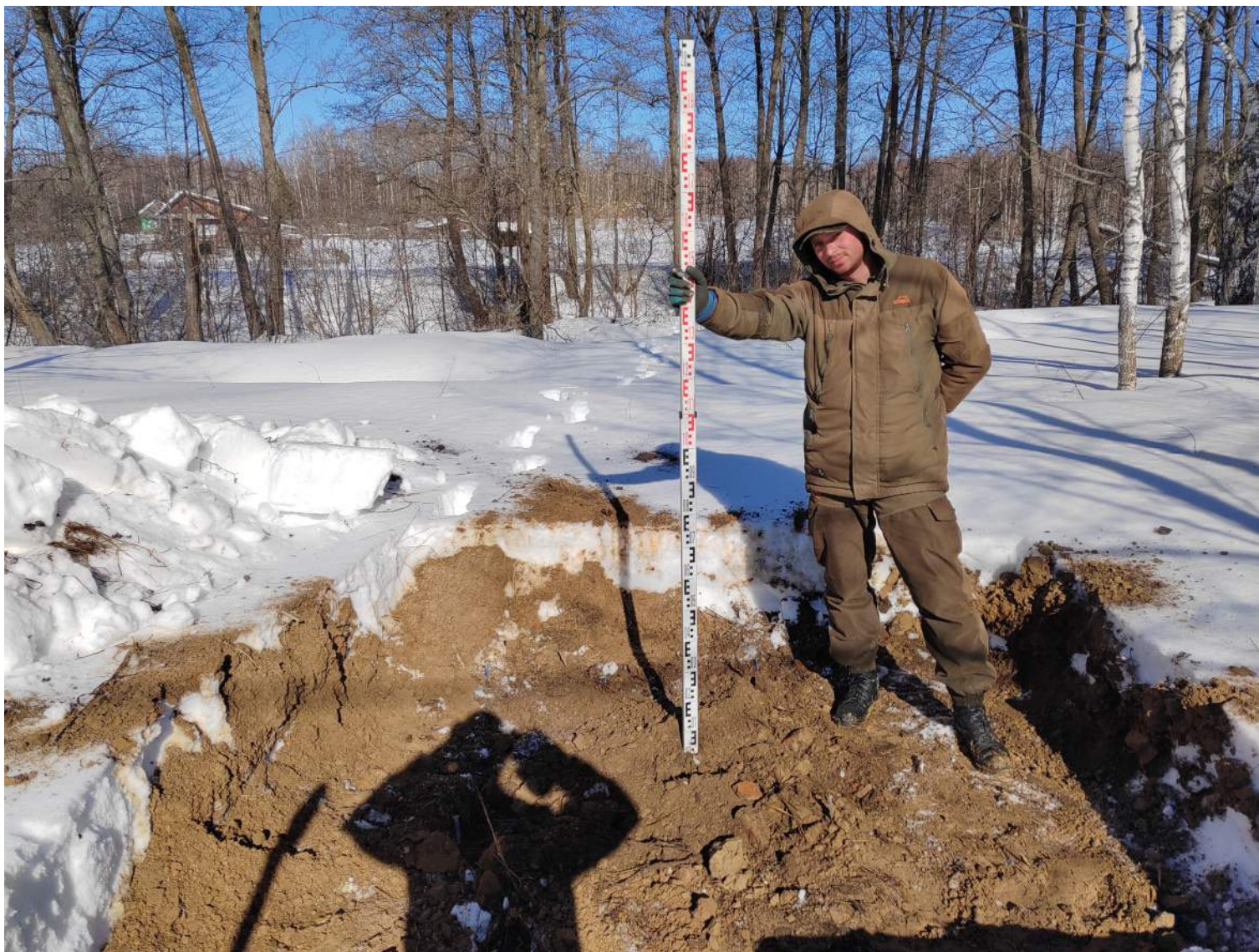
Илл. 22. Нижегородская обл., Городецкий р-н, межпоселковый газопровод к д. Караваево - 2024 г. Шурф 3. Видовая фотография закопанного шурфа. Фото с Ю.
